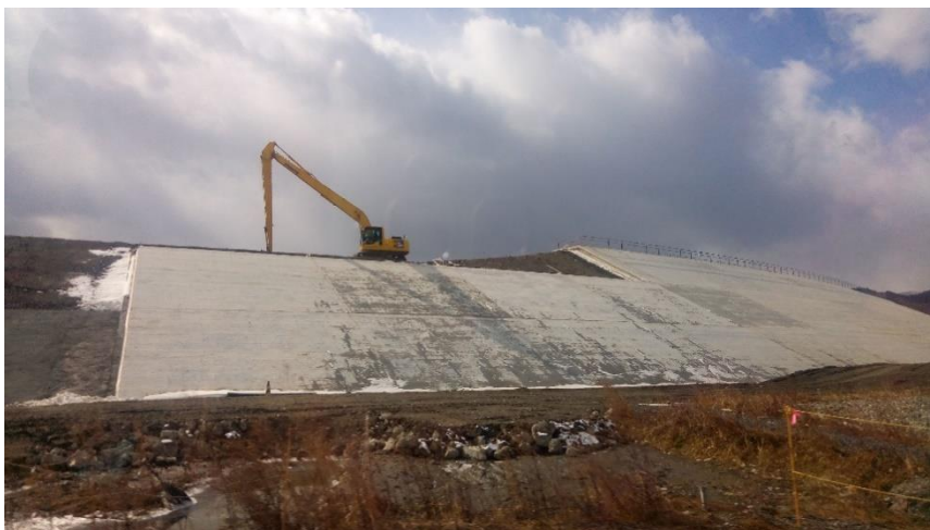
建設中の防波堤
